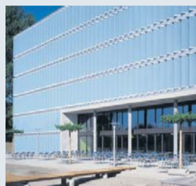
Das Haus der Zukunft des Wasserforschungsinstituts Eawag: Die Aussenfassade mit den Glaslamellen (o.) und die «schwebenden» Sitzungszimmer im Atrium (u.).
